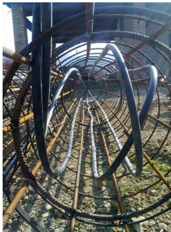
Circuito chiuso sfruttando i pali di fondazione
