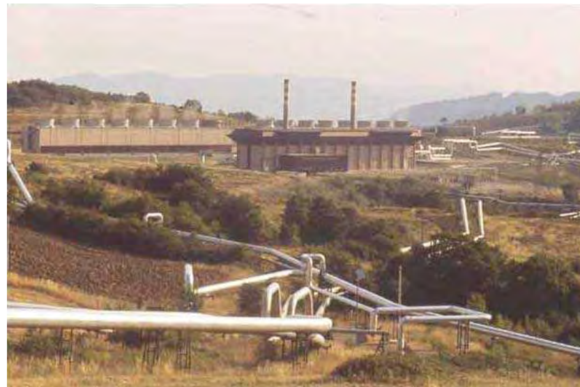
Impianto di Larderello
